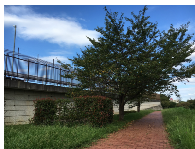
河川用地内に植栽(さくら・さつき) H16.H17.H22
