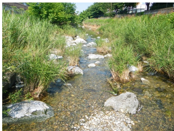
水制の下流側から(2012.6.26)
