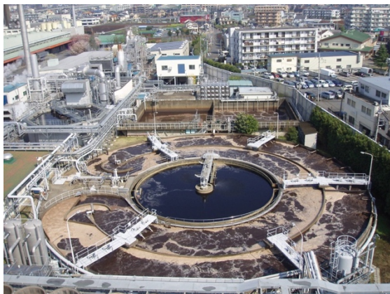
森永乳業東京多摩工場の高度浄化浄水池
