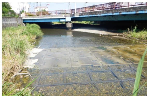
(写真4) 床固め工
