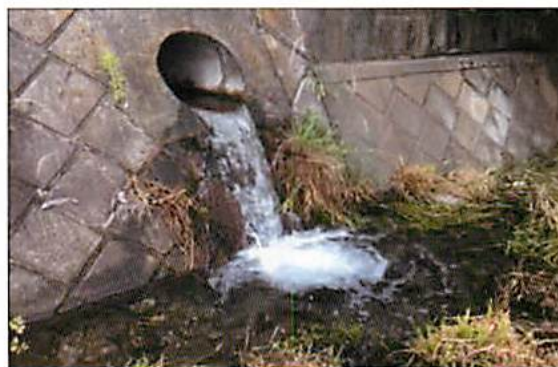
御成橋 JR 武蔵野線湧水。水は出ていました
