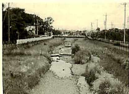
まりあ幼稚園前から野行前橋を見る
