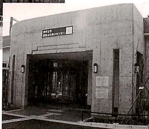
・恩多ふれあいセンター 正面入口
