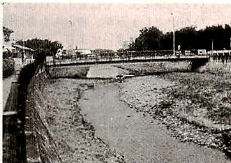
改修された区間
