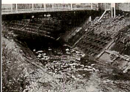
未改修の護岸
